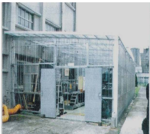
圖 3 核廢料試驗場房外部照片
